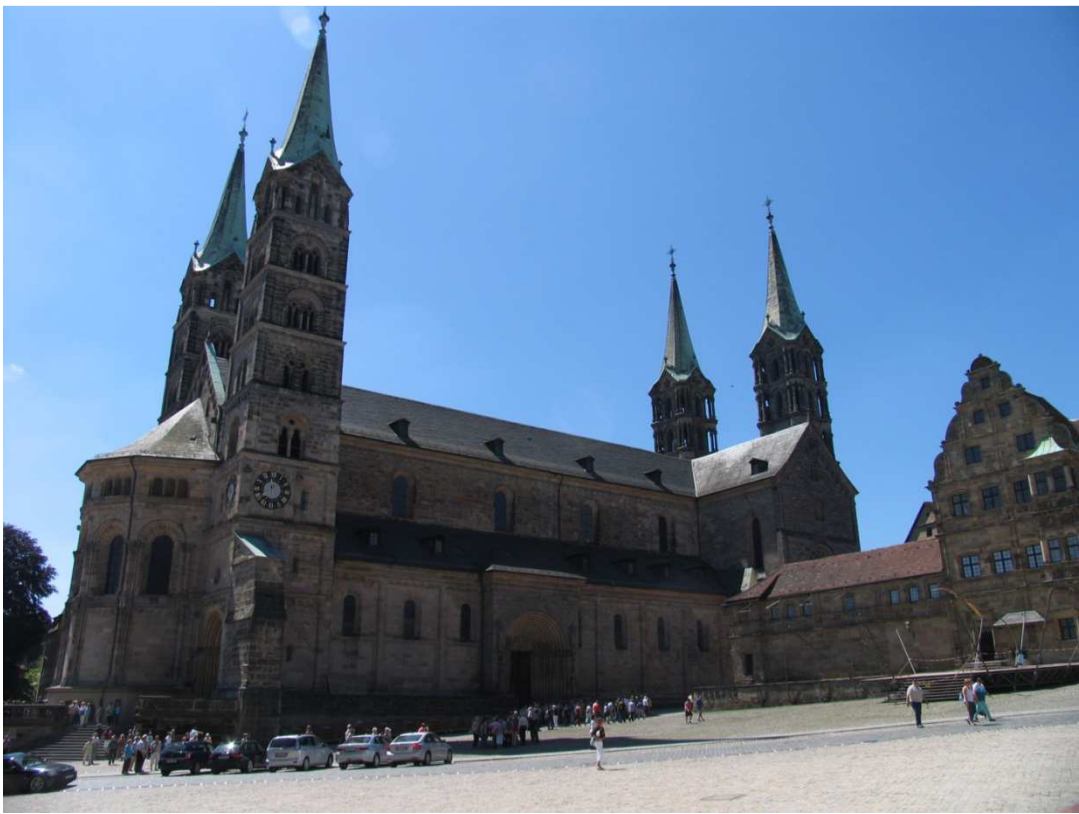
Der Bamberger Dom ist als so genannte Papstkirche gebaut d.h. mit einem Ost- und einem Westchor
